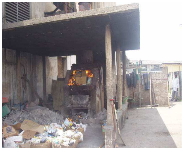
Picture 4: Un incinérateur de construction locale dans un centre de santé à Ibadan, Nigeria Source: Oketola et al., 2011
