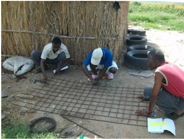
Figure 4 : fabrication d'une grille à 100mm, Beira
